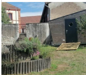
Mairie de Saint Bérain sur Dheune
