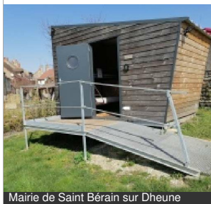
Mairie de Saint Bérain sur Dheune
